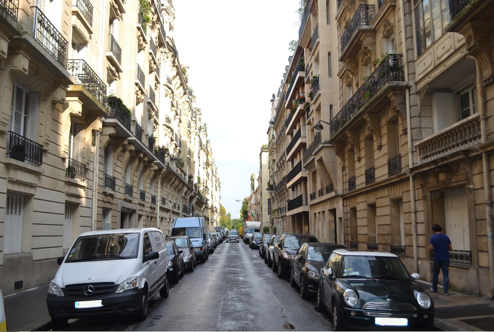
Appartement Lamberts; Rue Marbeau
